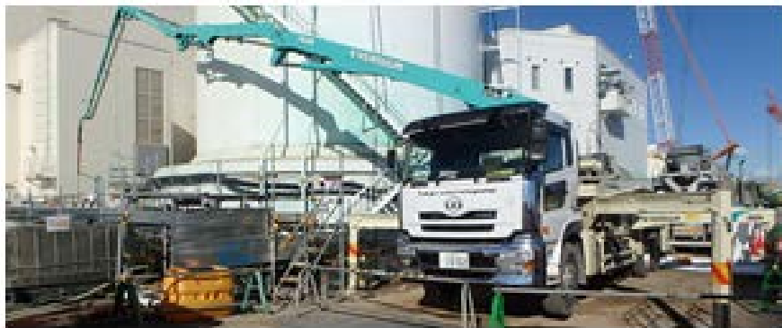
施工状況(「Hilo」の品質管理、運搬、打込み)
