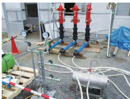
消火設備設置工事 試験風景
