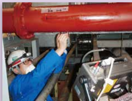
水平方向配管探傷状況
