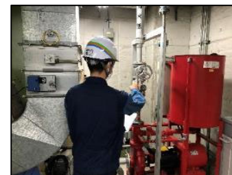
現地調査（目視調査）
