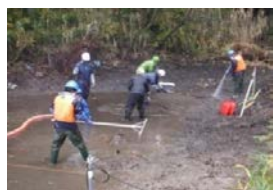
浅場での泥回収 (直接回収状況)
