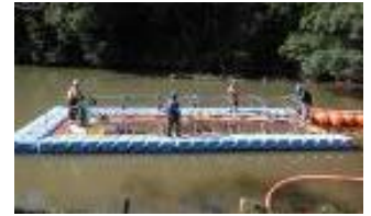
農水省の実証事業(天栄村)で実施したため池からの放射性物質回収作業の様子
