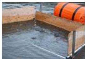
バケツでの泥回収 (直接回収状況)
