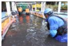
台船内での池底攪拌 (泥水化回収状況)
