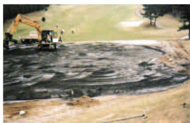
ゴルフ場地盤改良例
