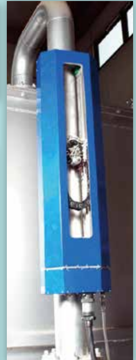
垂直配管の測定
