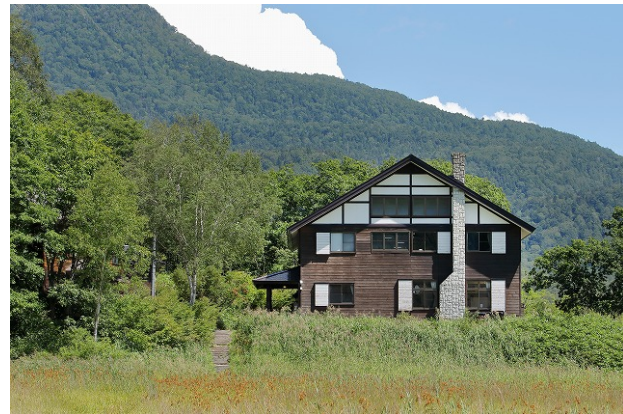
東電小屋 (ヨッピー吊橋側より)
